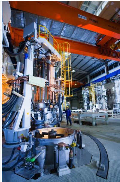
ESR plant (voestalpine Boehler Edelstahl)
