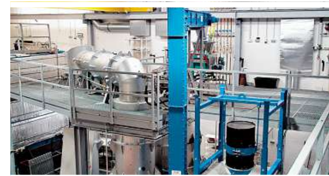
Die Flash-Reaktor-Pilotanlage im Technikum der Montanuniversität
