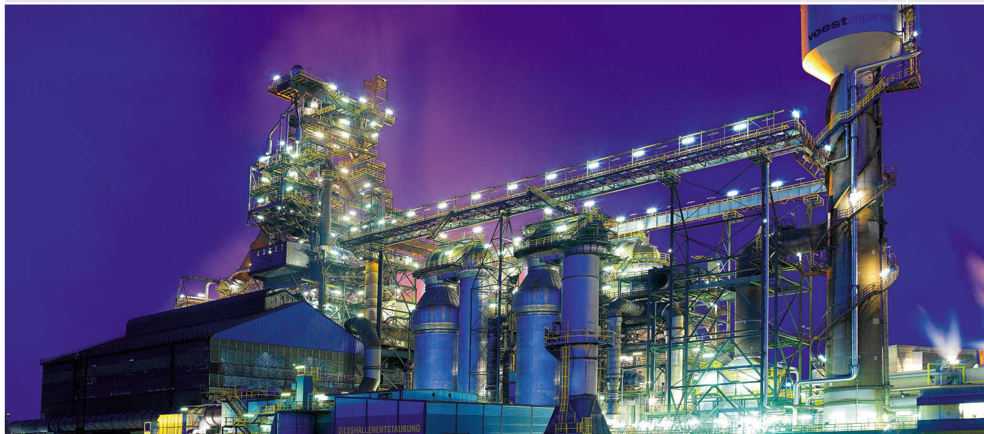
Mit dem K1-MET konnte ein bedeutendes Forschungszentrum für metallurgische und umwelttechnische Verfahrensentwicklung in Österreich aufgebaut werden. Der Hochofen A der voestalpine in Linz ist ein Beispiel für die weltweite Spitzenposition der österreichischen Metallurgie
