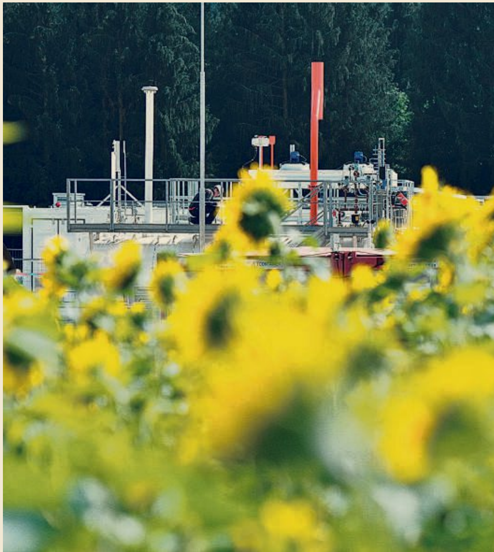
In der Gemeinde Gampern in Oberösterreich wird eine Forschungsanlage gebaut, die die gesamte Prozesskette rund um die Wasserstoffspeicherung im Untergrund abbildet.
