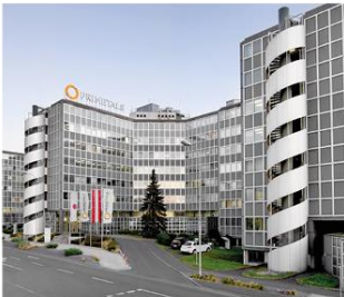
LINZ Primetals Technologies Austria GmbH
