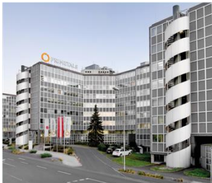
LINZ Primetals Technologies Austria GmbH
